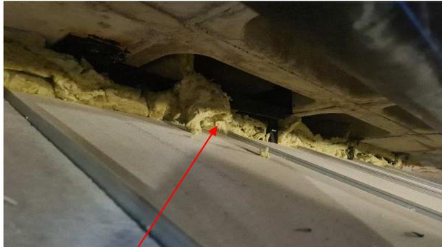
RETACADO INTERIOR ENTRE FALSO TECHO INTERIOR Y EXTERIOR CON LANA MINERAL
